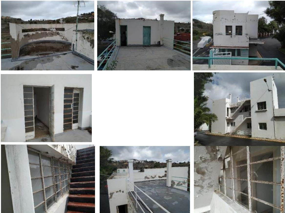
Fig. Nº 3.98. – Fotografías del estado actual del exterior de los pabellones de portero y garaje.
