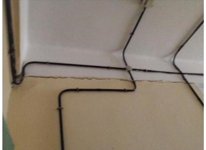
Fig. Nº 3.41.- En esta fotografía podemos apreciar las fisuras próximas al forjado.
