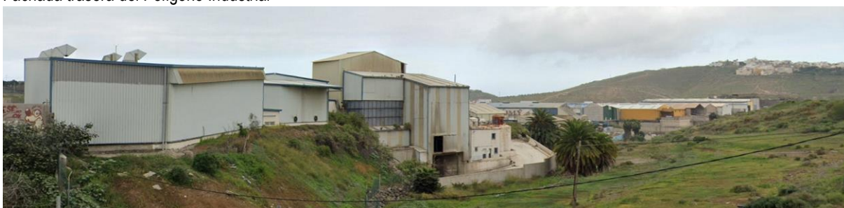
Fachada trasera del Polígono Industrial
