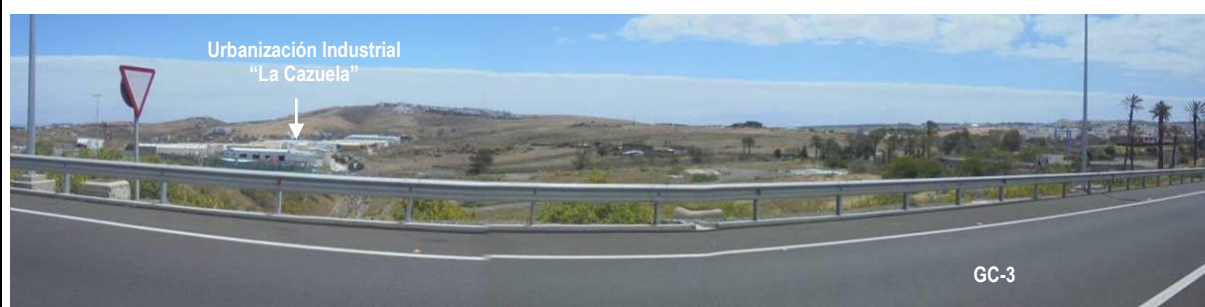
PVM.3.1. Vista del sector de estudio desde la Circunvalación de Las Palmas GC-3, tomada en la proximidad del enlace de conexión con la GC-300, junto al vértice noroeste del sector. La percepción visual del espacio es bastante completa.
