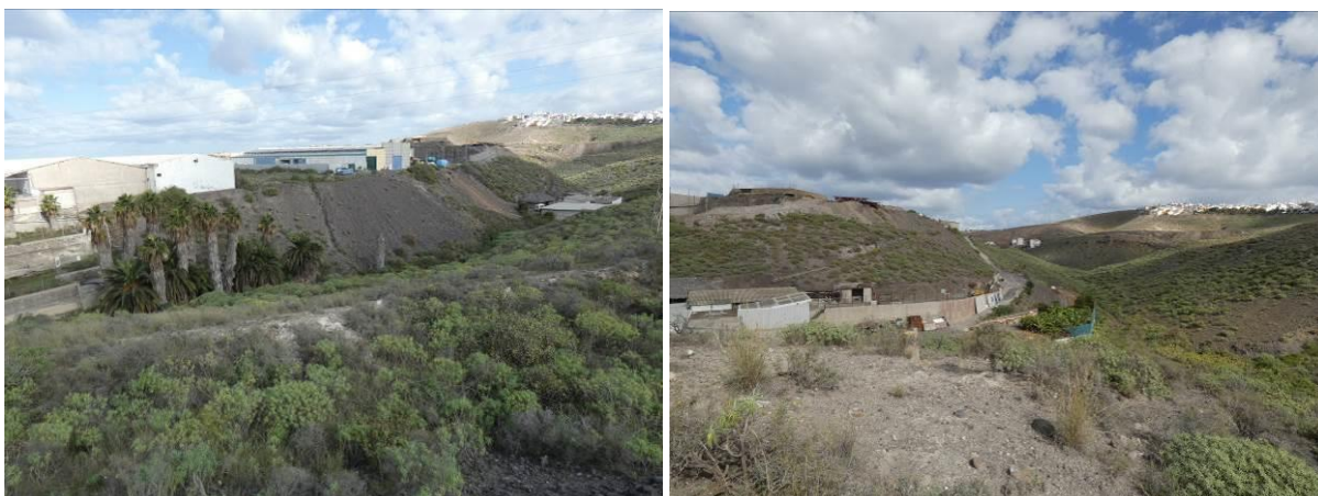
Terraplenes de grandes dimensiones, superficie edificada en el entorno del barranco.
