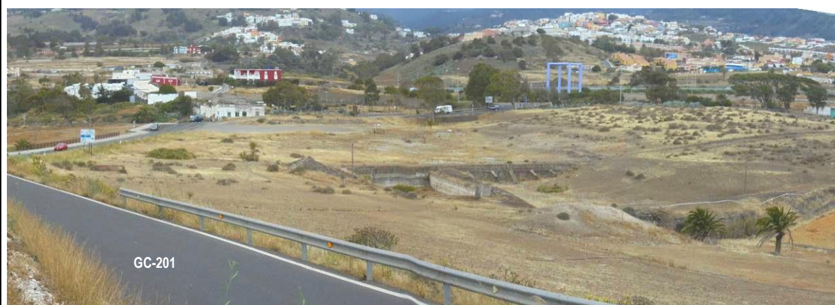
PVM.1.4. Panorámica del sector de estudio desde la Carretera GC-201 a la altura de la Finca de los Sifones. Vistas hacia el sur.
