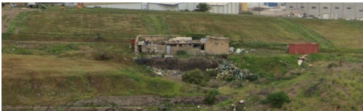
Construcciones en estado ruinoso, muros agrícolas, presencia de residuos, etc.
