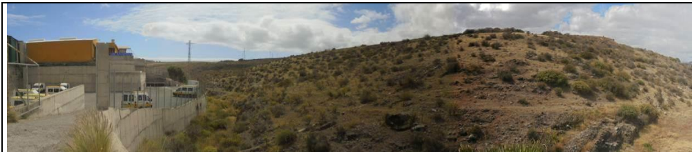
PVF.4.3. Percepción del sector de estudio desde la parte trasera de naves del sector industrial de La Cazuela. Vistas orientadas hacia el noreste.
