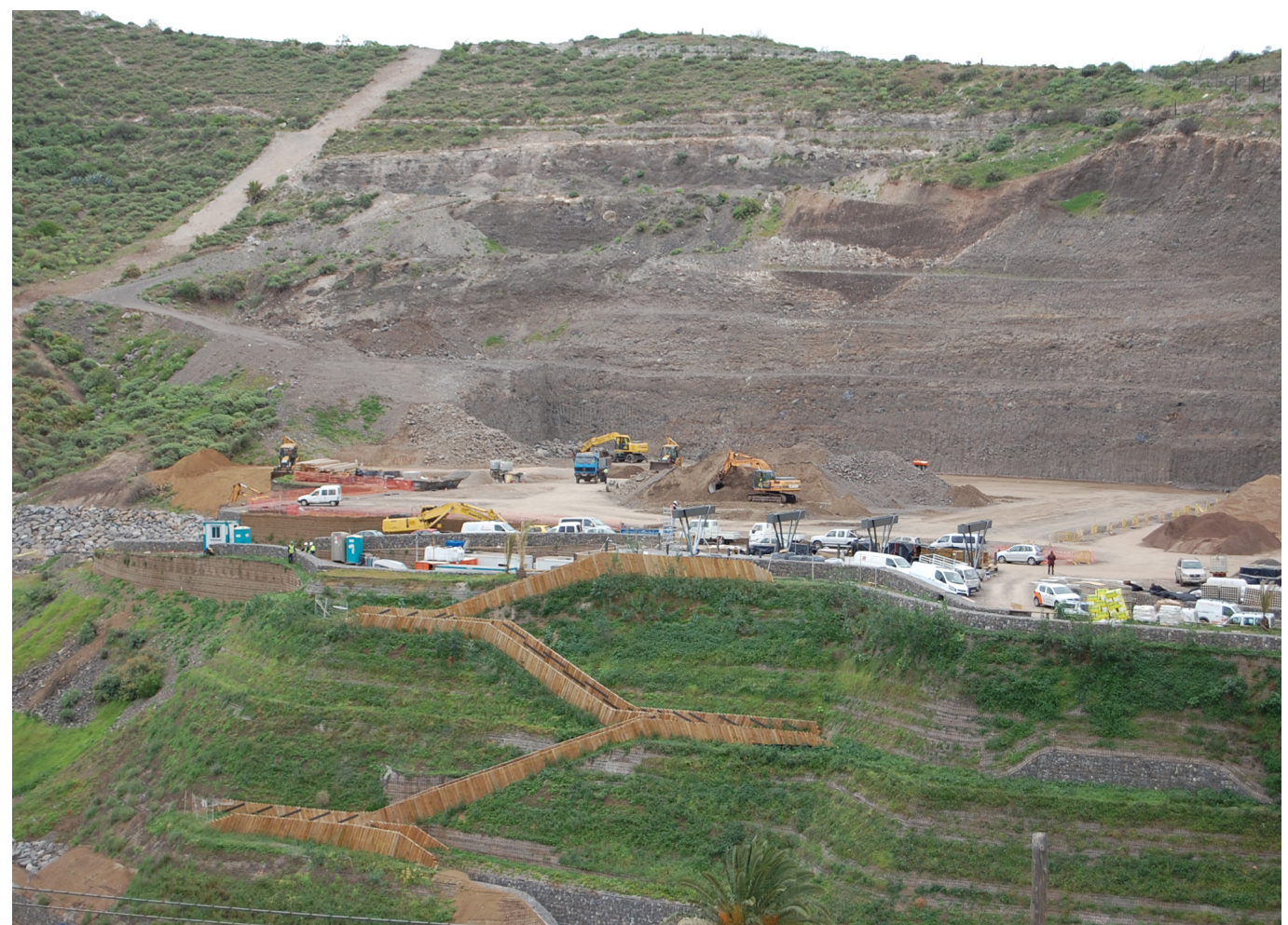
Ejemplo de muro ecológico en la Ciudad Deportiva de Barranco Seco (UDLP), durante el proceso de colonización de la vegetación. Fuente: LPA Studio.
