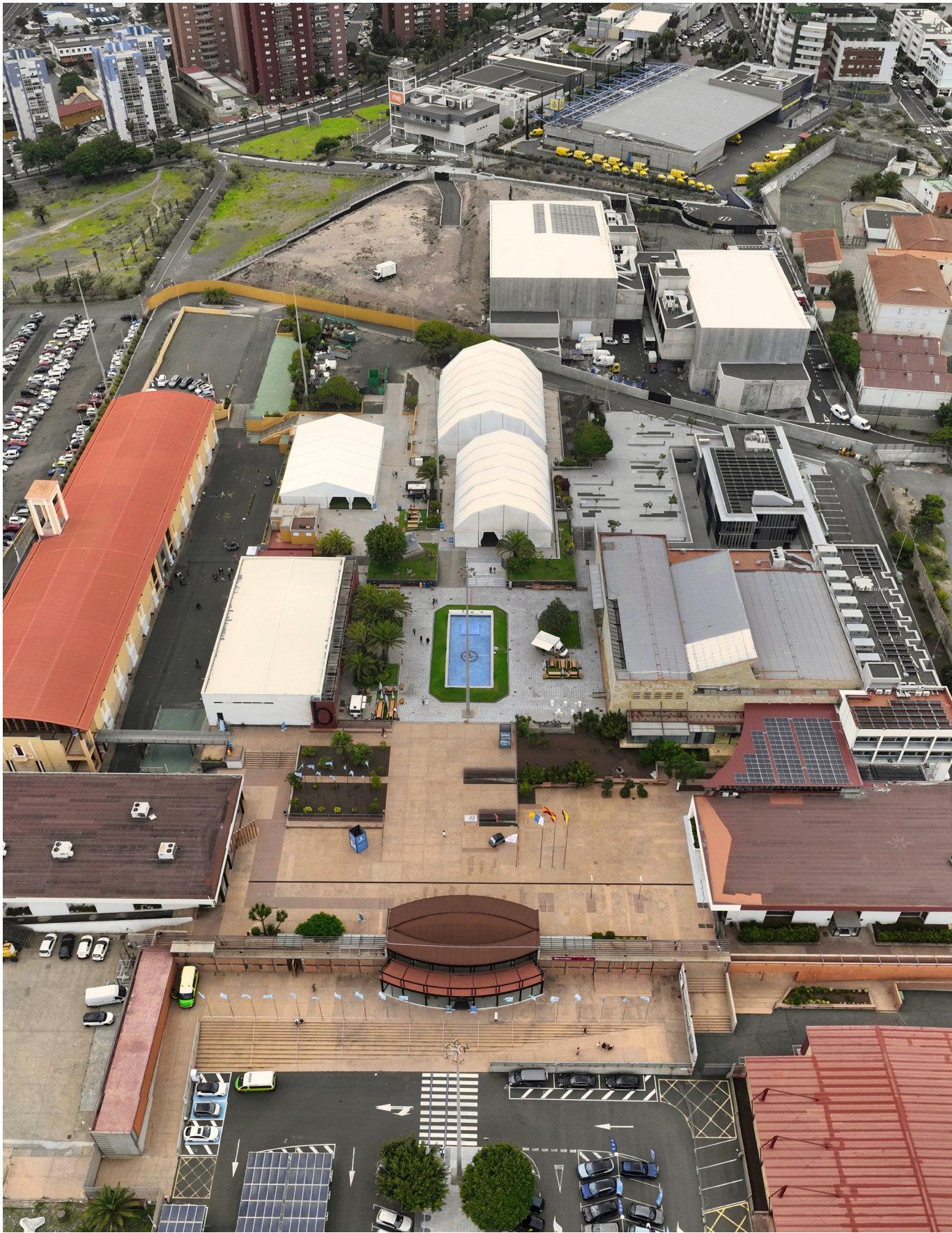
Vista aérea parcial del Sistema General SG-11 en su estado actual. Fuente: INFECAR.
