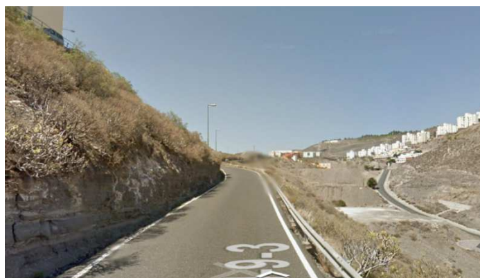
Zona no accesible para senda peatonal
