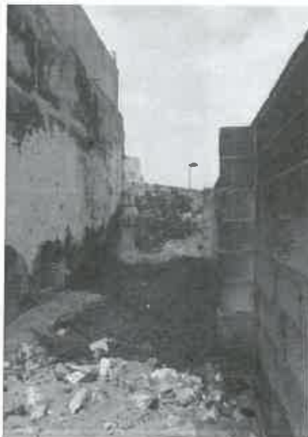
Interior de la parcela que da hacia la calle Marina.
