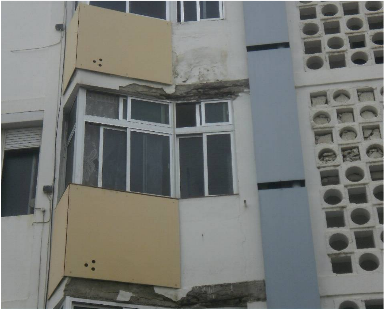
Detalle del deterioro en fachada principal.
