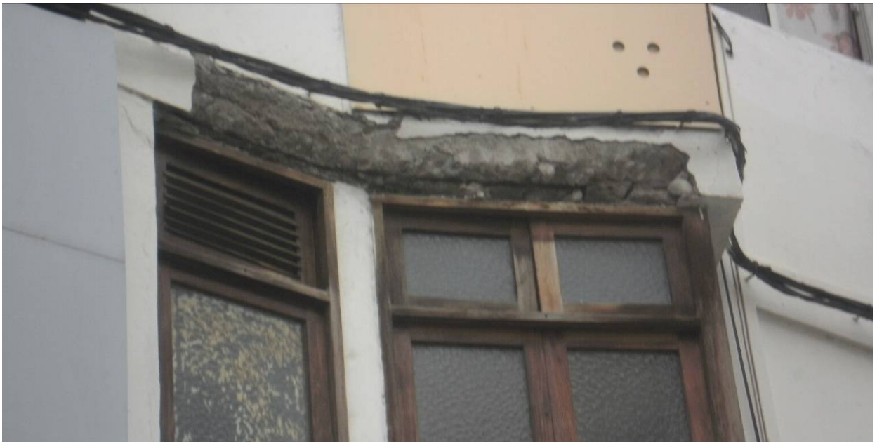
Detalle del deterioro en fachada principal.
