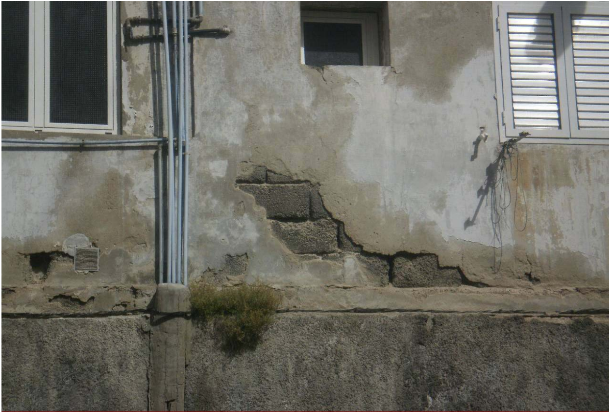
Detalle del deterioro en fachada trasera.
