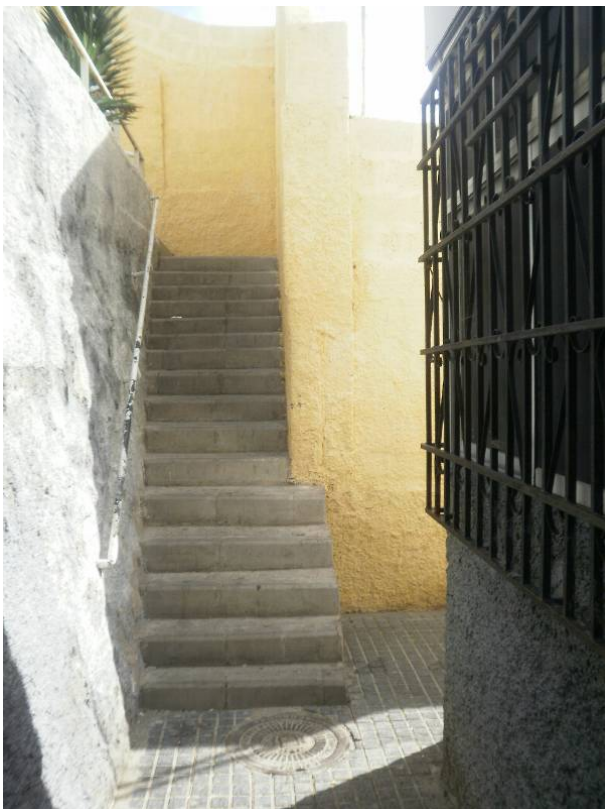
Más ejemplo de falta de coordinación entre rasantes y accesos.
