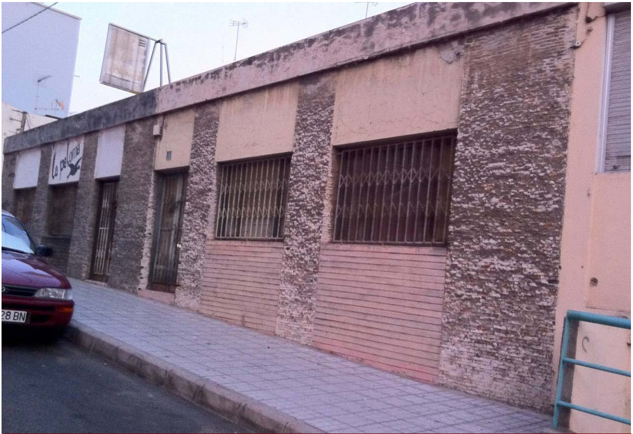
Imagen de local comercial en desuso.
