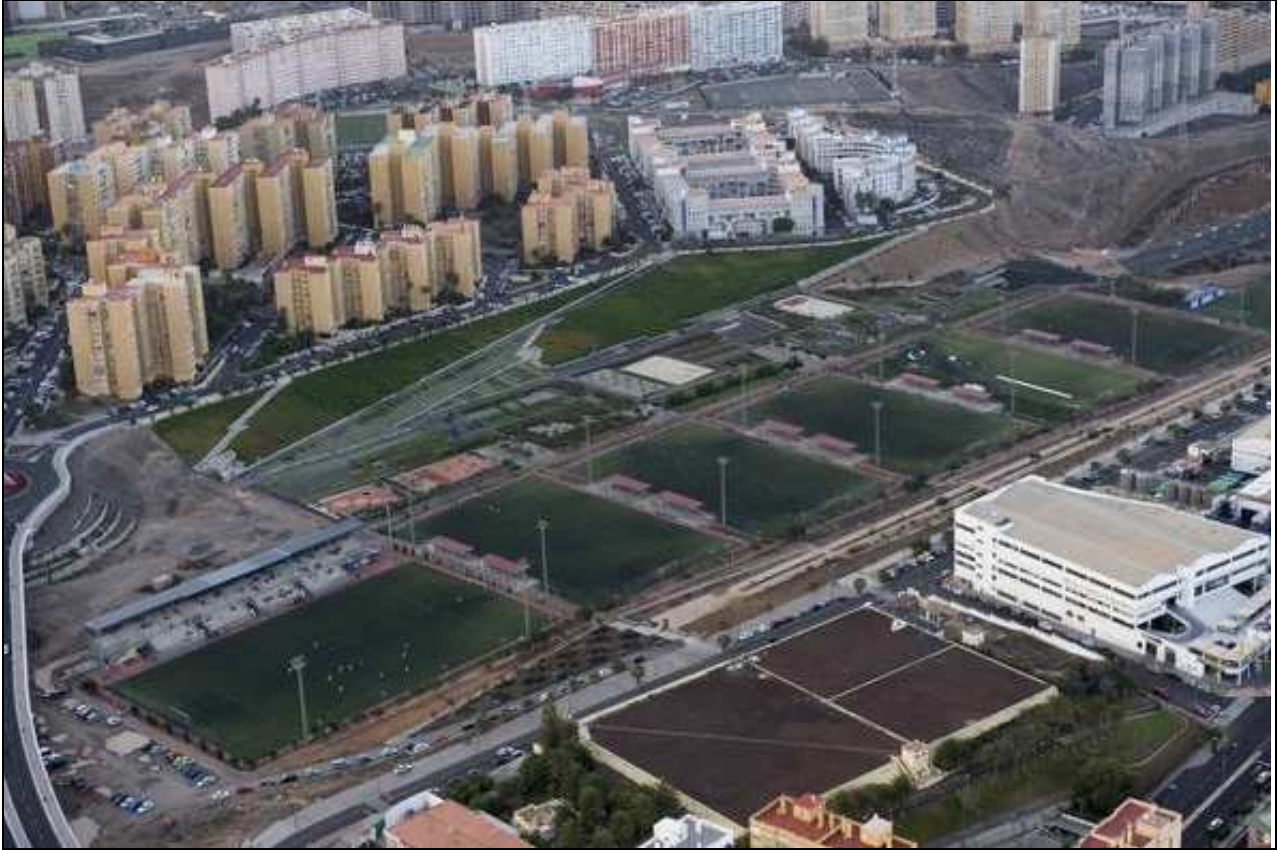
Fig.2. Integración del SG-09 en el Barranco de La Ballena (abajo)
