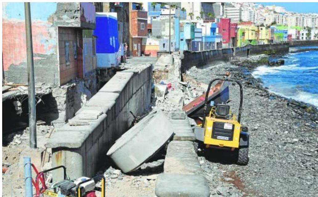
Obra de reparación del muro del paseo de San Cristóbal. ARCADIO SUÁREZ
