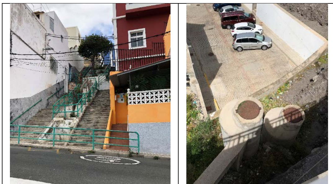
figura 31. Muestra del estado de los cableados e instalaciones en el ámbito
