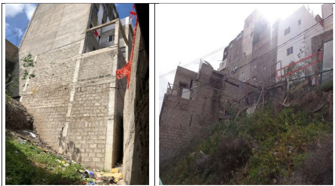
figura 18. Medianeras vistas sin tratar. Grave impacto especialmente para para los bordes
