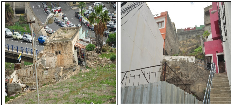
Fotográfico 11, 12, 13 y 14. Inadecuaciones edificatorias en el ámbito del API-05
