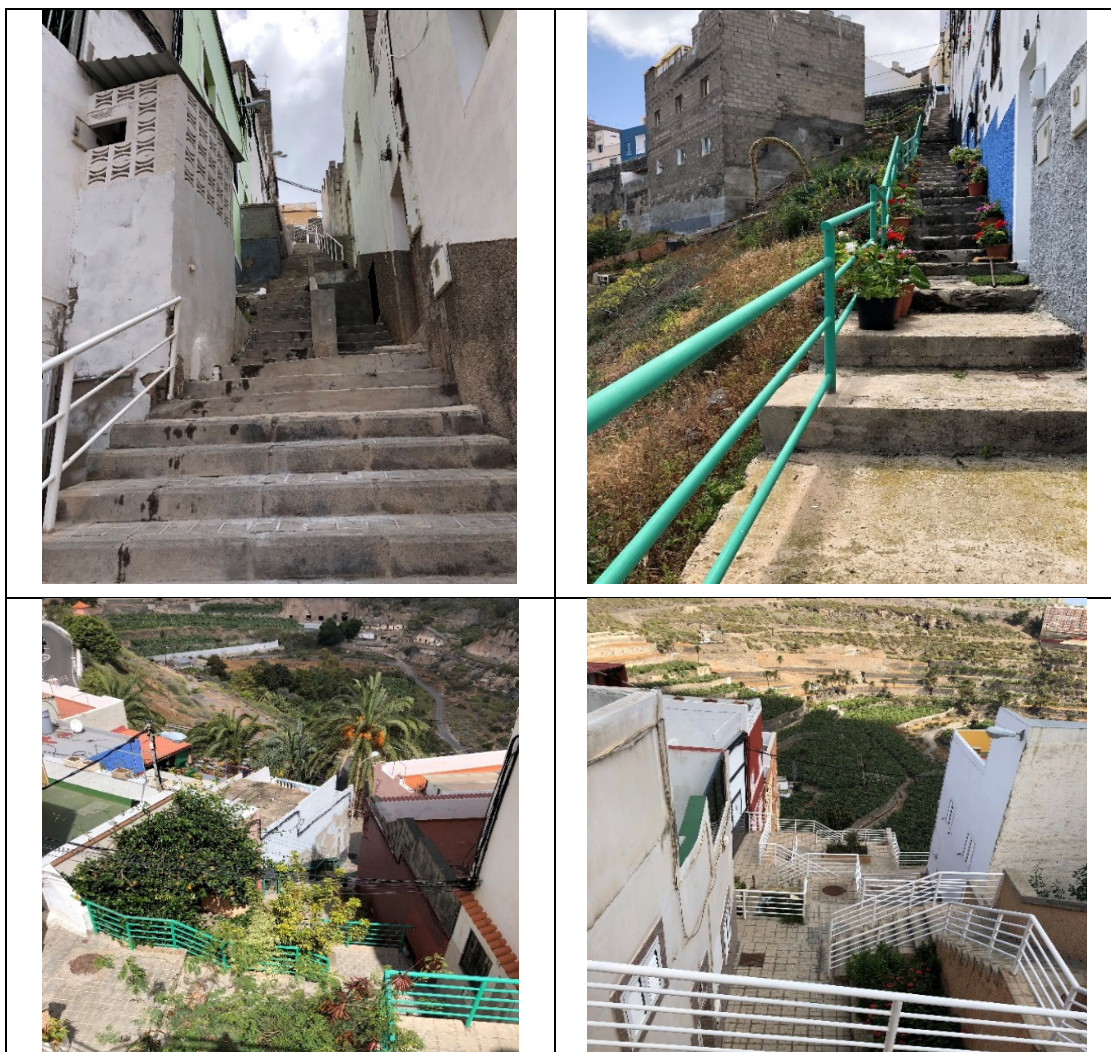
Figura 29. Distintos ejemplos de escaleras en el Risco de San Roque
