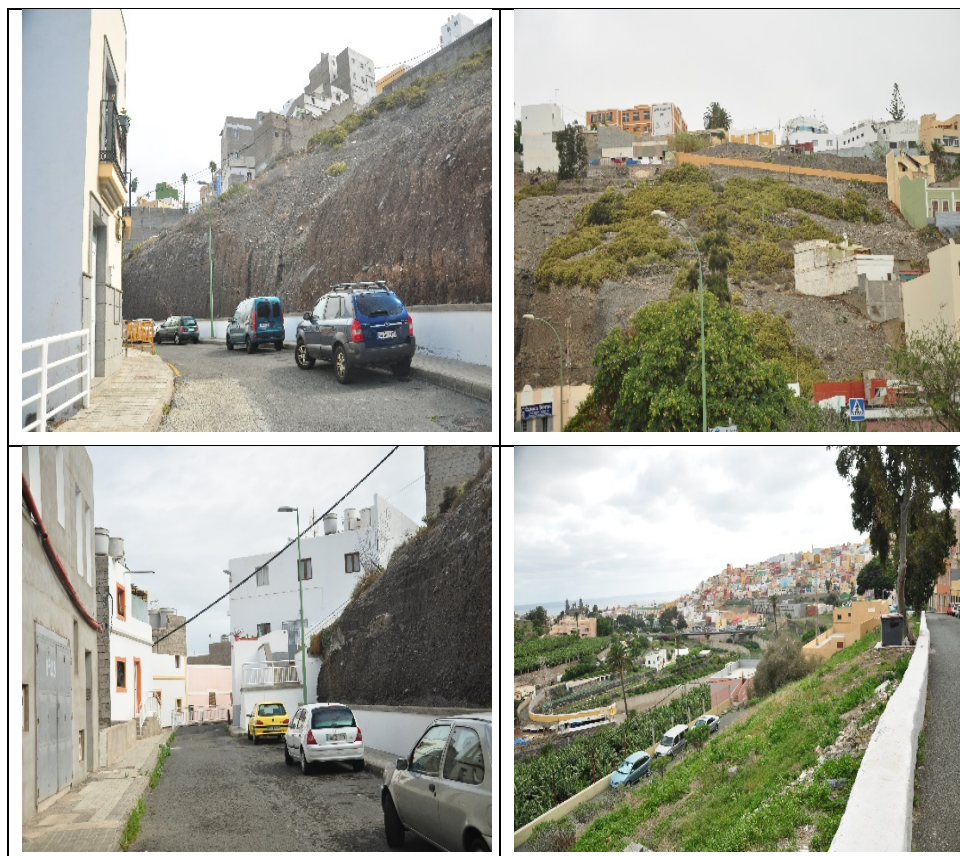
Fotográfico 5, 6, 7 y 8. Taludes inestables, puntos de escorrentía concentrada, áreas de encharcamiento y lugares expuestos a viento en el ámbito del API-05
