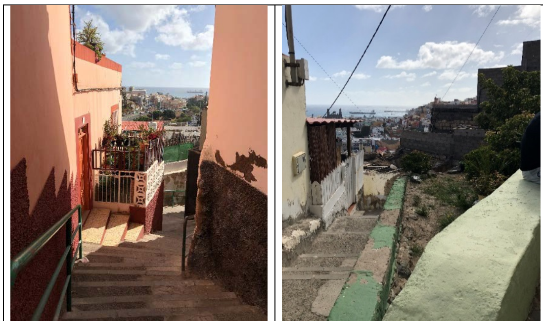
figura 12. Pasaje peatonal en la calle Faro
