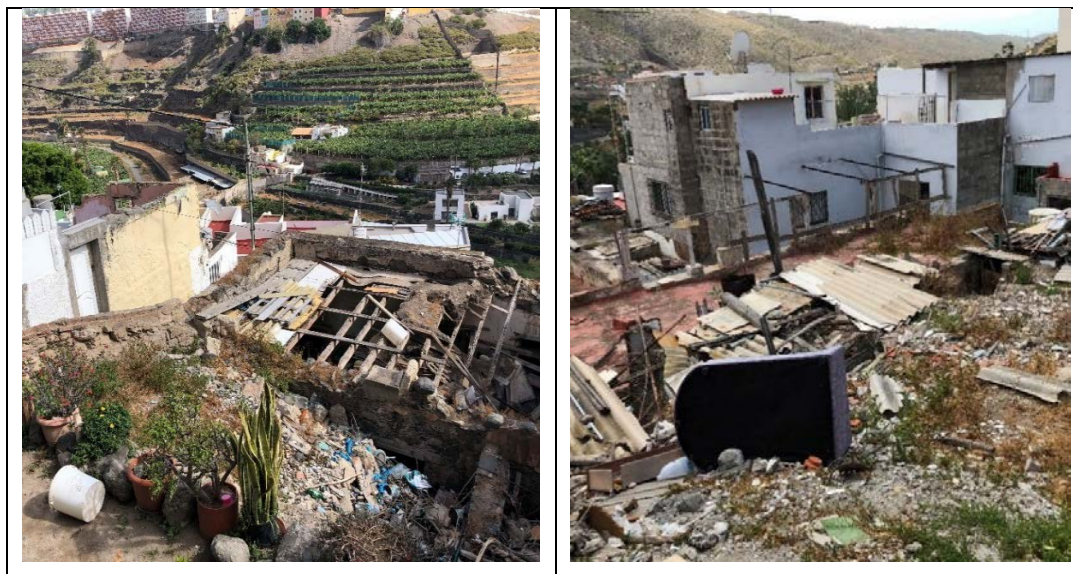
Figura 15. Vertido de escombros en solares abandonados
