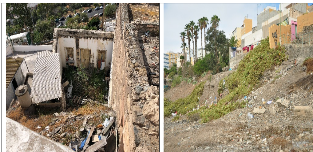
Fotográfico 9 y 10. Basuras y escombros en diferentes sectores del Risco de San Roque
