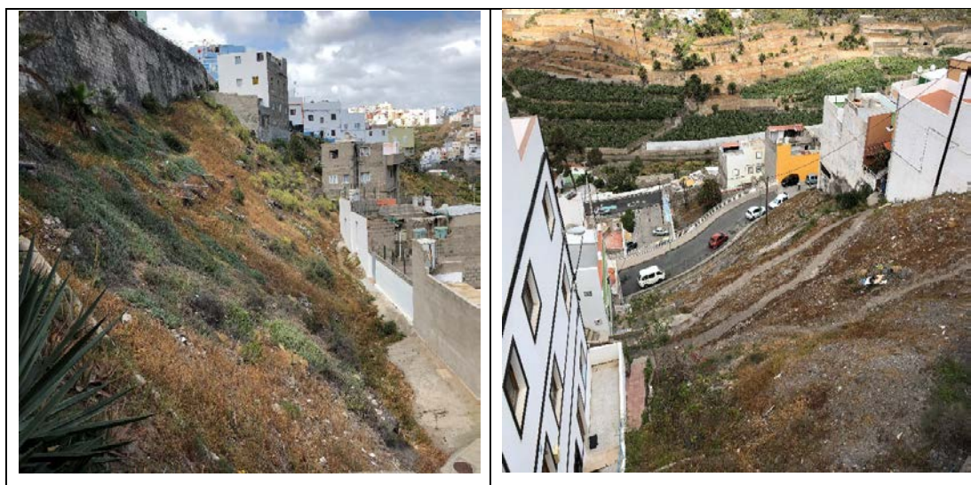
figura 16. Laderas de excesiva pendiente, libres de edificación
