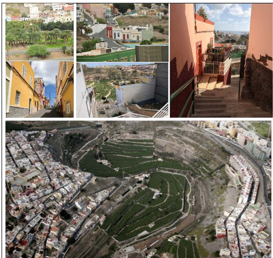
figura 2. Distintas visiones del Risco de San Roque y su relación con Barranco Guiniguada y Rehoyas Altas
