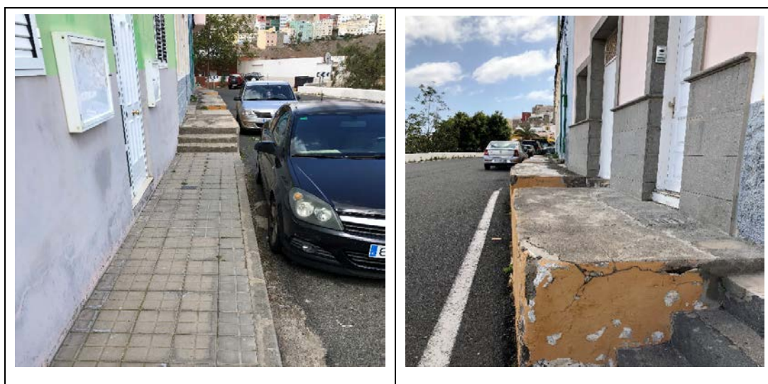
figura 9. Acera en la calle Andenes
