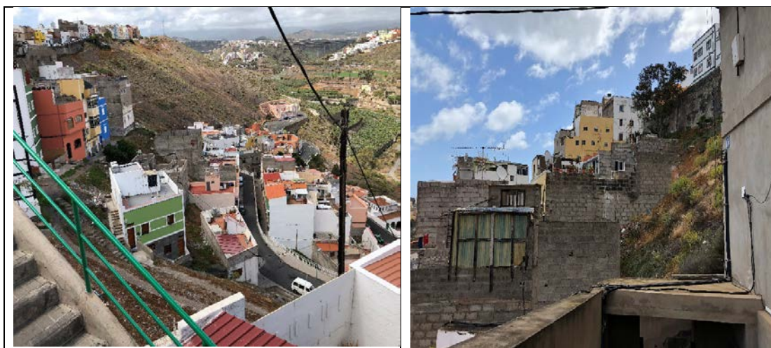
figura 35. Ejemplos del resultado de la mala aplicación de la Normativa. Heterogeneidad y medianeras vistas
