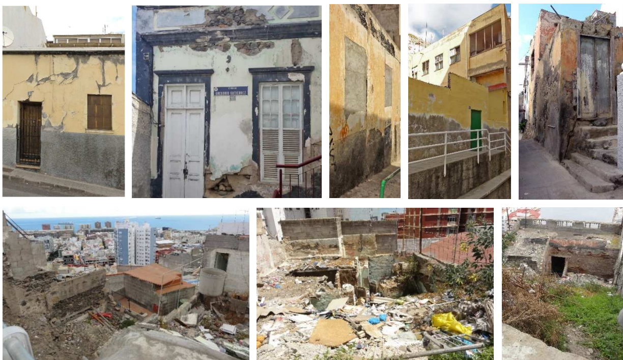
Edificaciones en mal estado, solares y ruinas en San Nicolás
