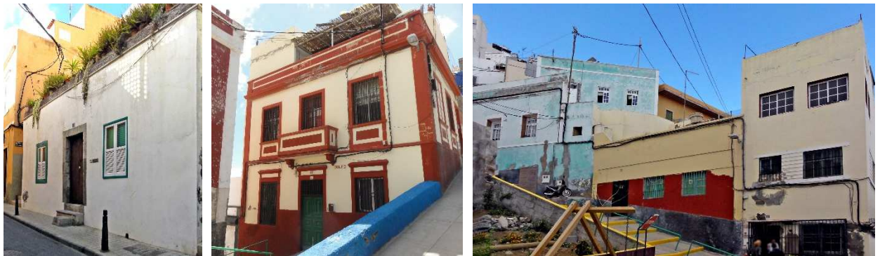
Edificaciones de distintas alturas (entre 1 y 3 plantas)
