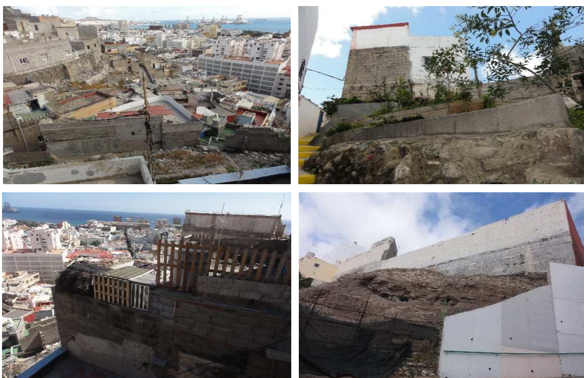
Fotográfico 11, 12, 13 y 14. Inadecuaciones edificatorias en el ámbito del API-03
