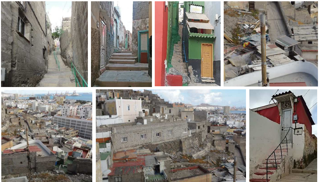
Infraviviendas y detalles de las malas calidades de materiales y acabados
