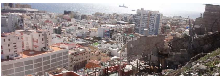
Vistas desde algunos de los solares y parcelas en ruinas
