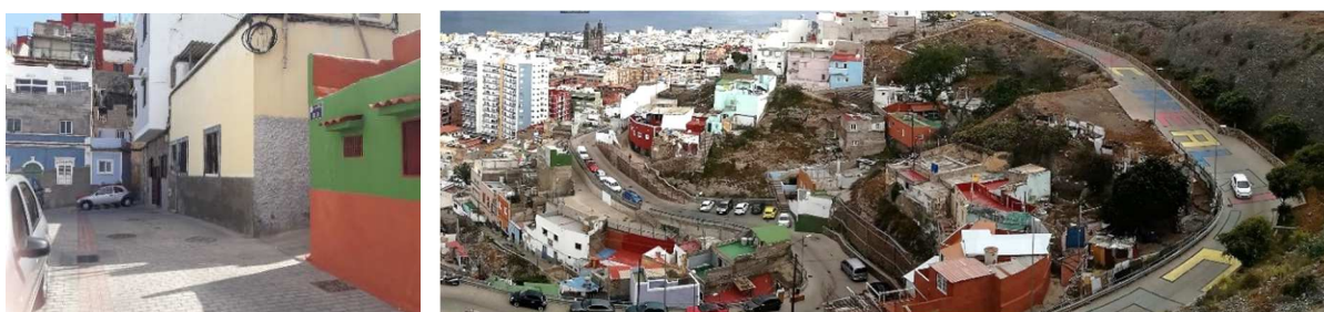
Vario ejecutado recientemente por GEURSA
