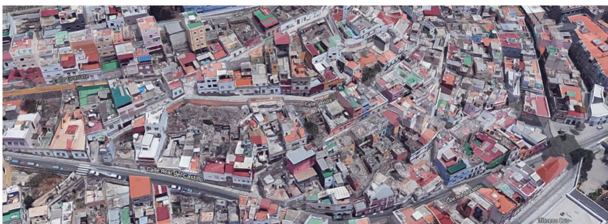
Vista aérea del barrio donde se puede observar el gran número de edificaciones en ruinas (Google Maps 17/05/2018)
