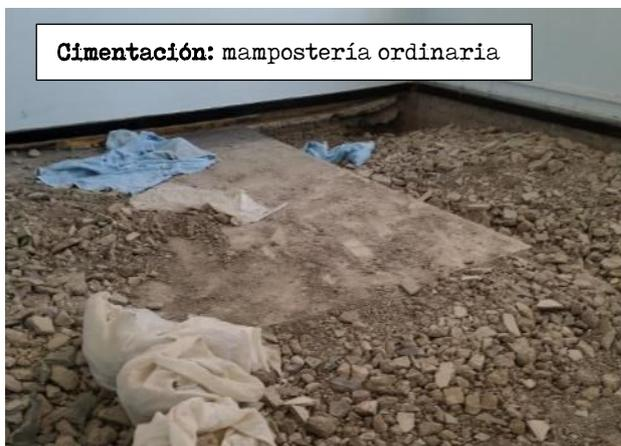
La cimentación de los pilares es en base a unos planos de hormigón armado en hierros en cuadrícula y con un espesor entre 15 a 20 cm.
