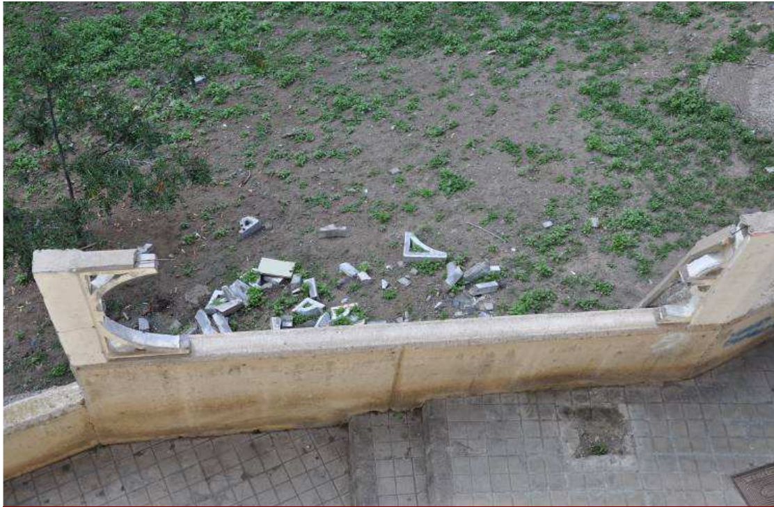
Detalle de los impactos ambientales preexistentes.
