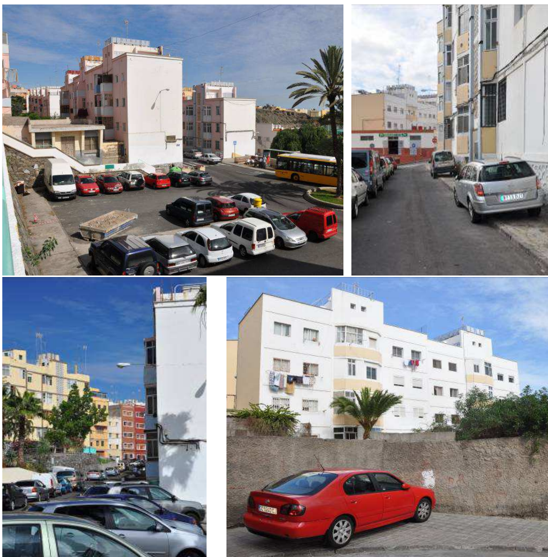
Detalle de los impactos ambientales preexistentes.
