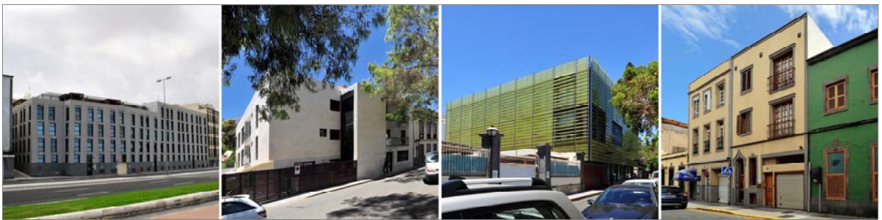
Imágenes de inmuebles construidos durante los últimos 20 años en Vegueta
