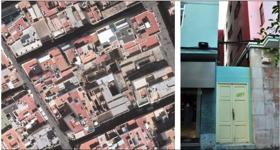
Espacio libre interior a manzana ordenado en el PEPRI-2001 y acceso desde calle Arena
