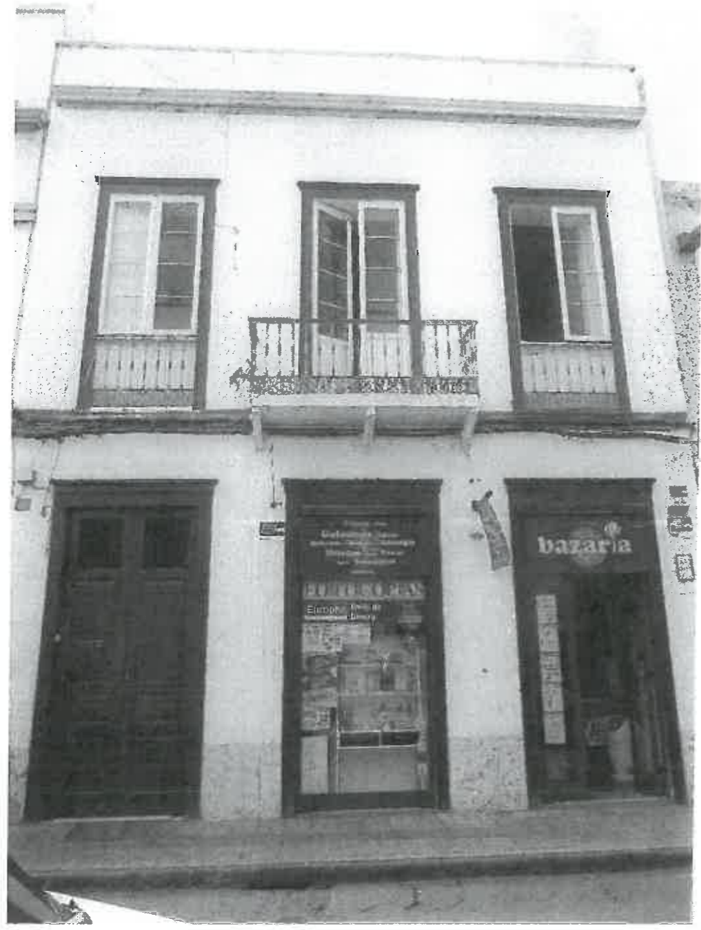
01_ IMAGEN DE LA FACHADA ACTUAL
