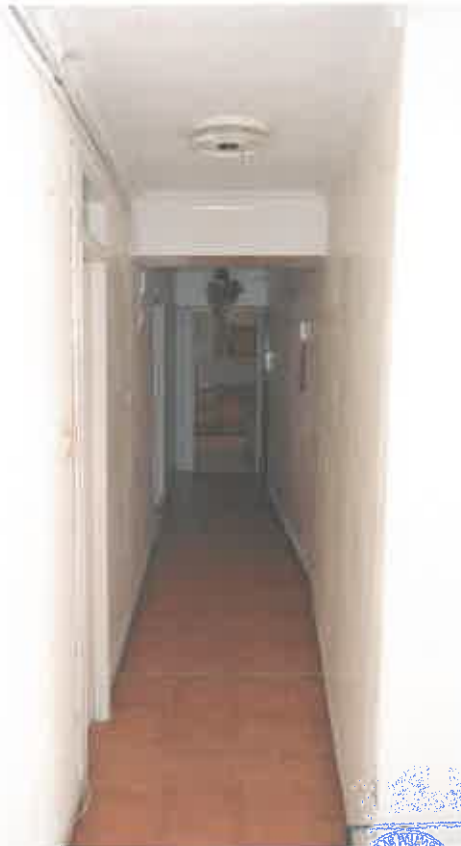
Primer nivel vivienda. (Crujías interiores)
