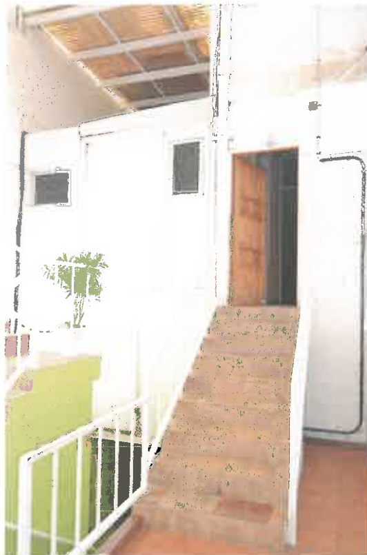
Escalera a segundo nivel vivienda. (nivel forjado planta alta original hacia c/ Triana)
