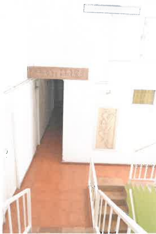
Acceso escalera a primer nivel vivienda
