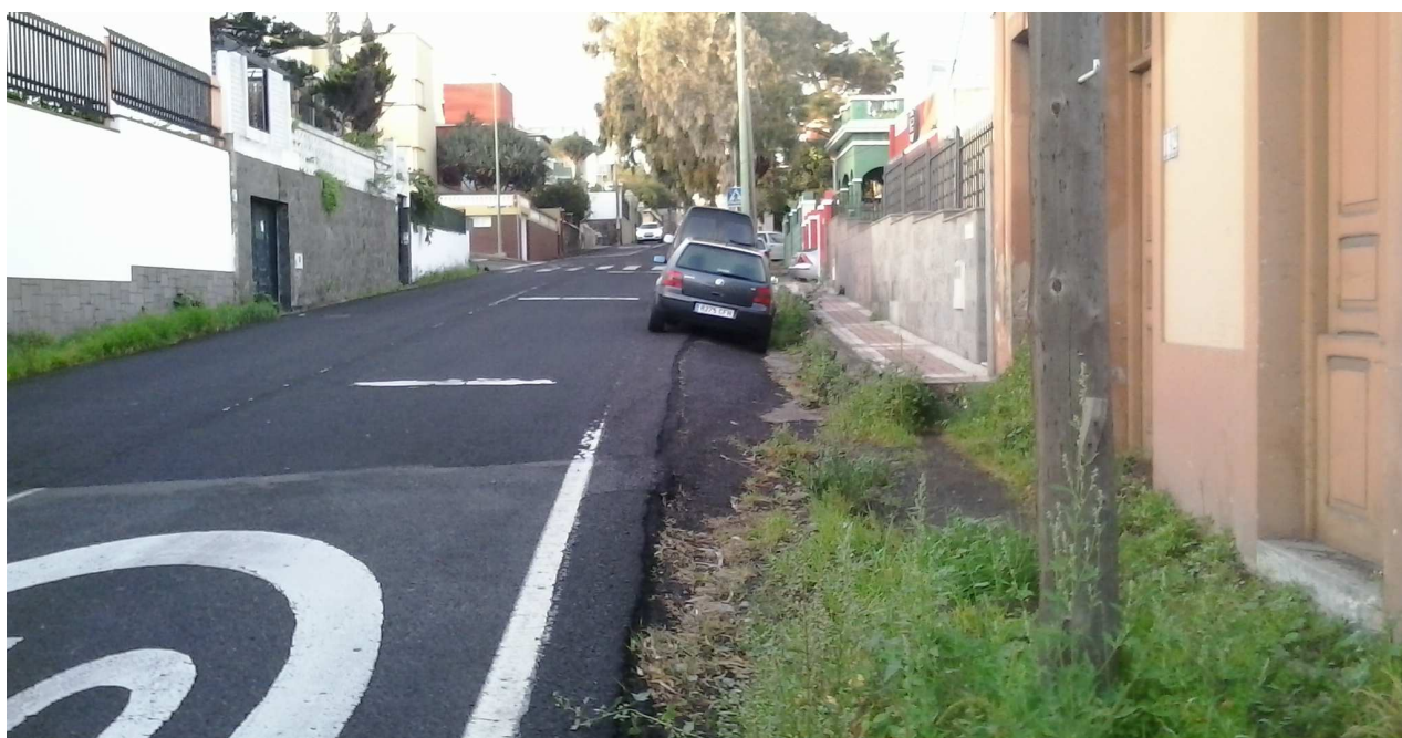
Imagen nº7. Vista de la carretera de Tafira a la altura de la cll Joaquín Mir. P.K 1,100 Vía de doble sentido de circulación con margen en uno de los lados y en donde se hace evidente el desnivel de calzada existente entre el vial y las edificaciones.
