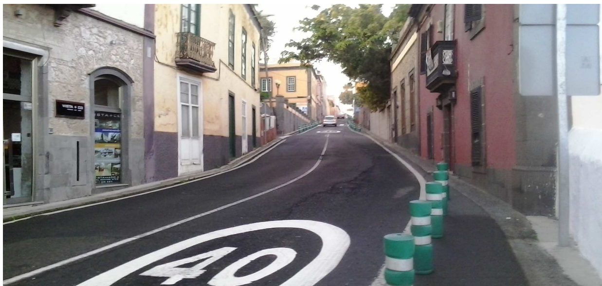
Imagen nº2. Vista de la carretera de Tafira a la altura de la c. Párroco Bartolomé Hdez. P.K 0,300 Vía de doble sentido de circulación sin apenas márgenes a ambos lados.
