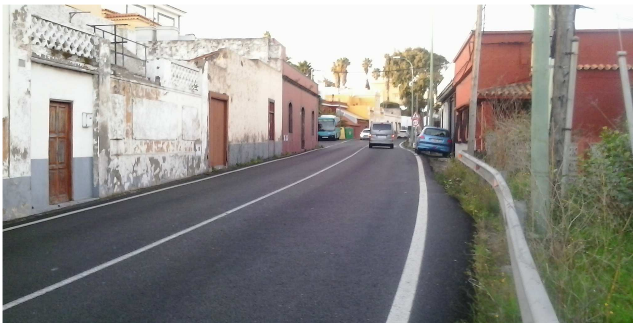
Imagen nº5. Vista de la carretera de Tafira a la altura de la cll La Tronera. P.K 0,700 Vía de doble sentido de circulación sin apenas márgenes a ambos lados.
