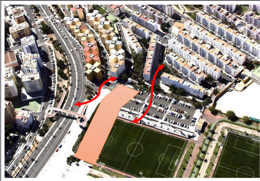
Situación actual del área donde se ubicará la nueva edificación residencial
