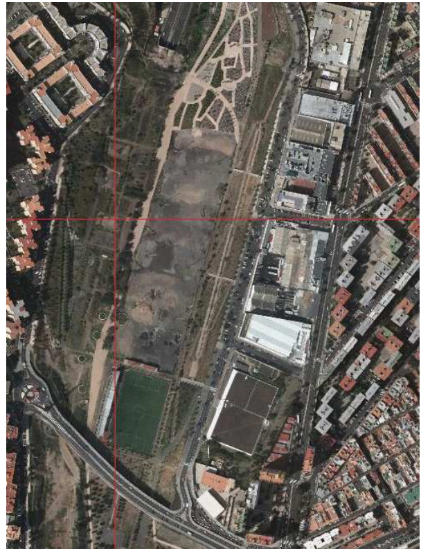
Espacios libres del subsistema C ejecutados parcialmente.
