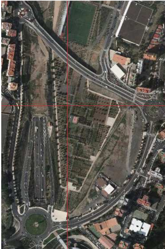
Espacios libres del subsistema D ya ejecutados.
