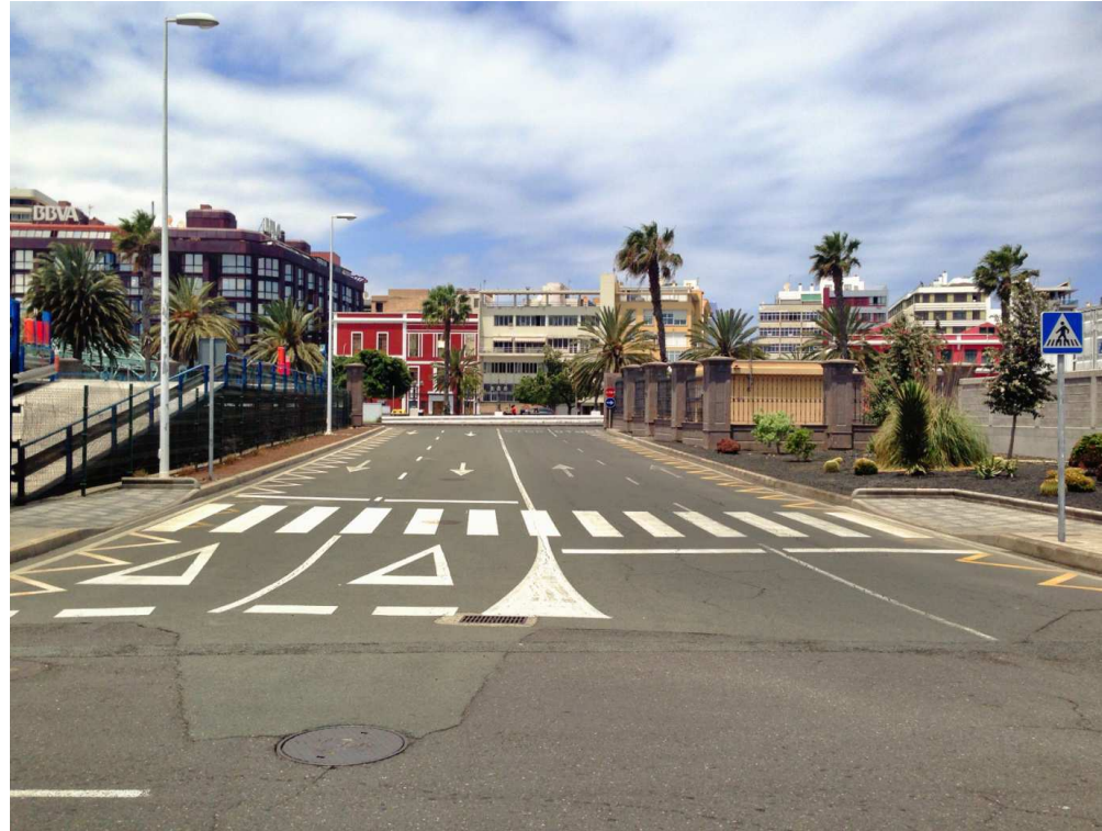
Ramal de conexión con GC-1/ Avenida Marítima
