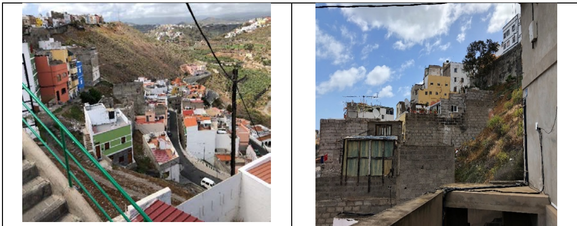
Ejemplos del mal resultado de la aplicación de la Normativa. Medianeras vistas e inacabadas.
