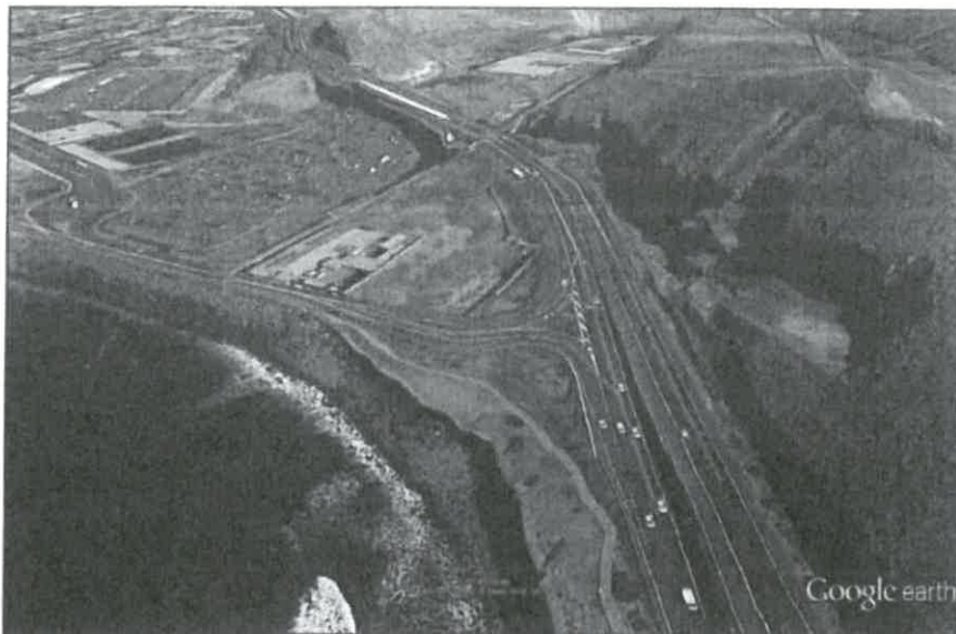
Fig Nº5. Imagen oblicua de los desmontes a los que se hace referencia y que se encuadrarian en el fondo escénico y que afecta a las vistas en dirección oeste desde el paseo litoral. Fuente: Google Earth
