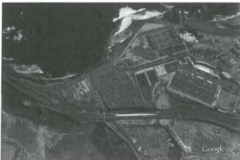
Fig.1. Estado actual de las parcelas objeto del informe de referencia. Fuente: Google Earth
