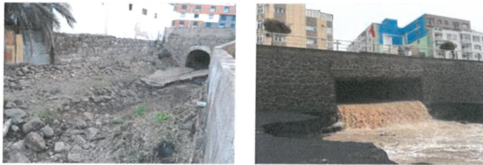
Ilustración 5 - Cauce del tramo final del Barranco de La Ballena. Fuente: Miplayadelascanteras y EuropaPress
