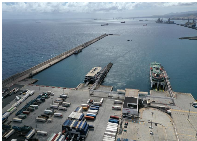
Estado de la Terminal de Pasajeros en la dársena de África y dique Nelson Mandela (año 2020)
