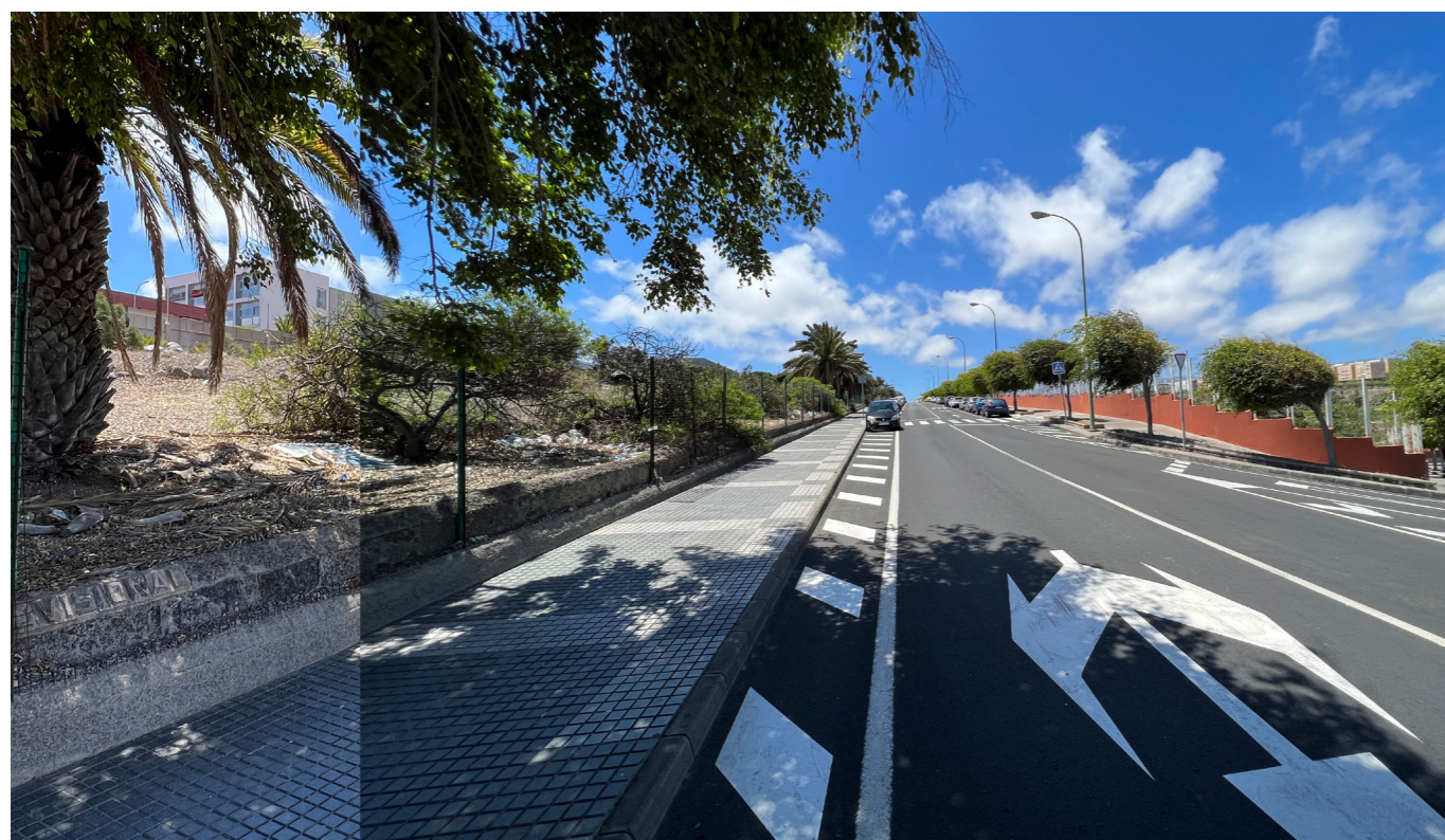
Vista de la franja verde colindante con la C/Alfárez Provisional, con posibilidad de transformarla en una infraestructura verde. Fuente: LPA Studio.
