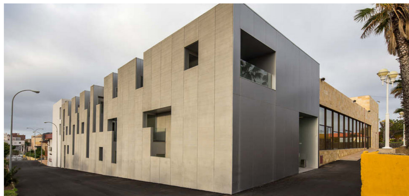
Alzado poniente del Edificio Incube. Fuente: LPA Studio.
