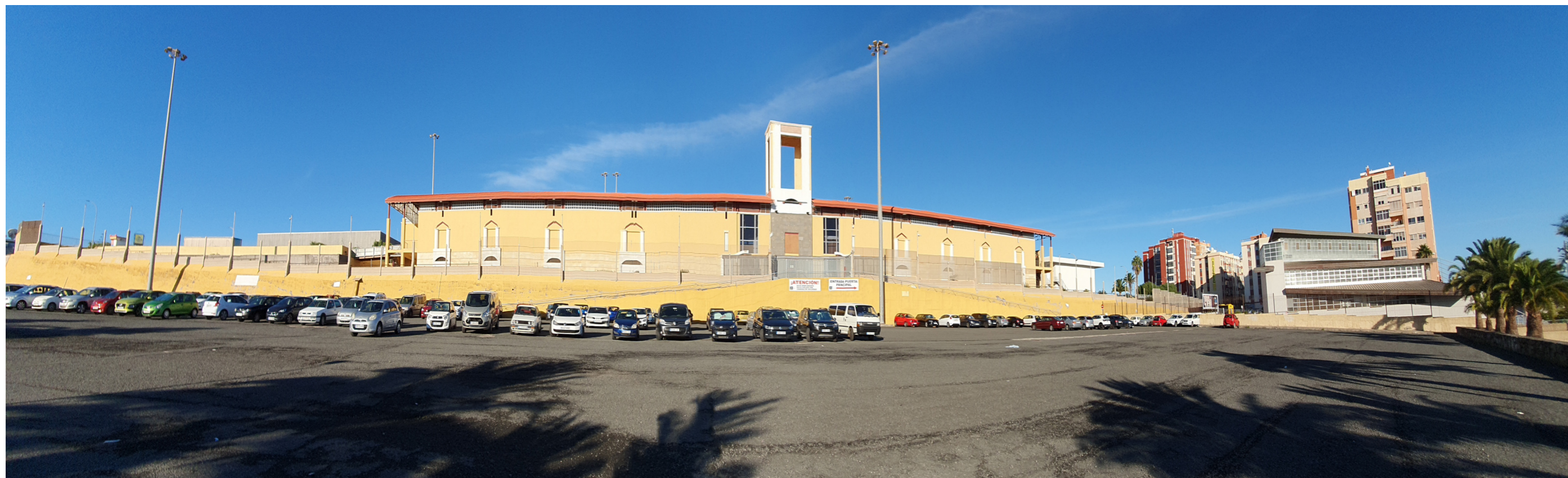
Vista naciente del aparcamiento principal y del Pabellón 7 del Recinto Ferial de Canarias. Fuente: LPA Studio.
