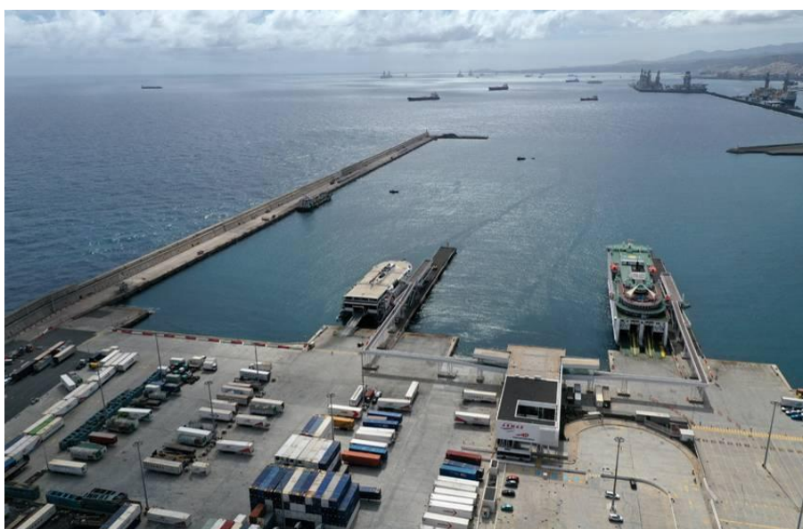
Estado de la Terminal de Pasajeros en la dársena de África y dique Nelson Mandela (año 2020)
