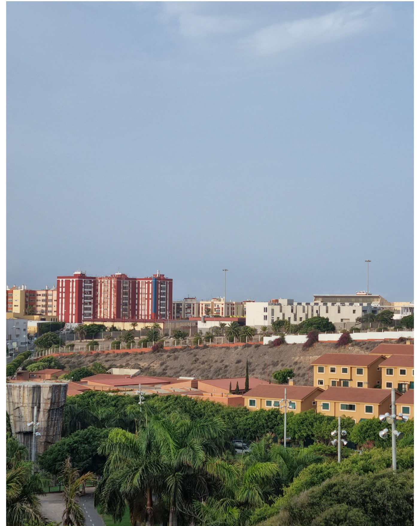
Fotografía: vista poniente del ámbito de estudio, con el Recinto Ferial al fondo (Pabellón 6, Edificio Incube y Palacio de Congresos). Fuente: LPA Studio.
