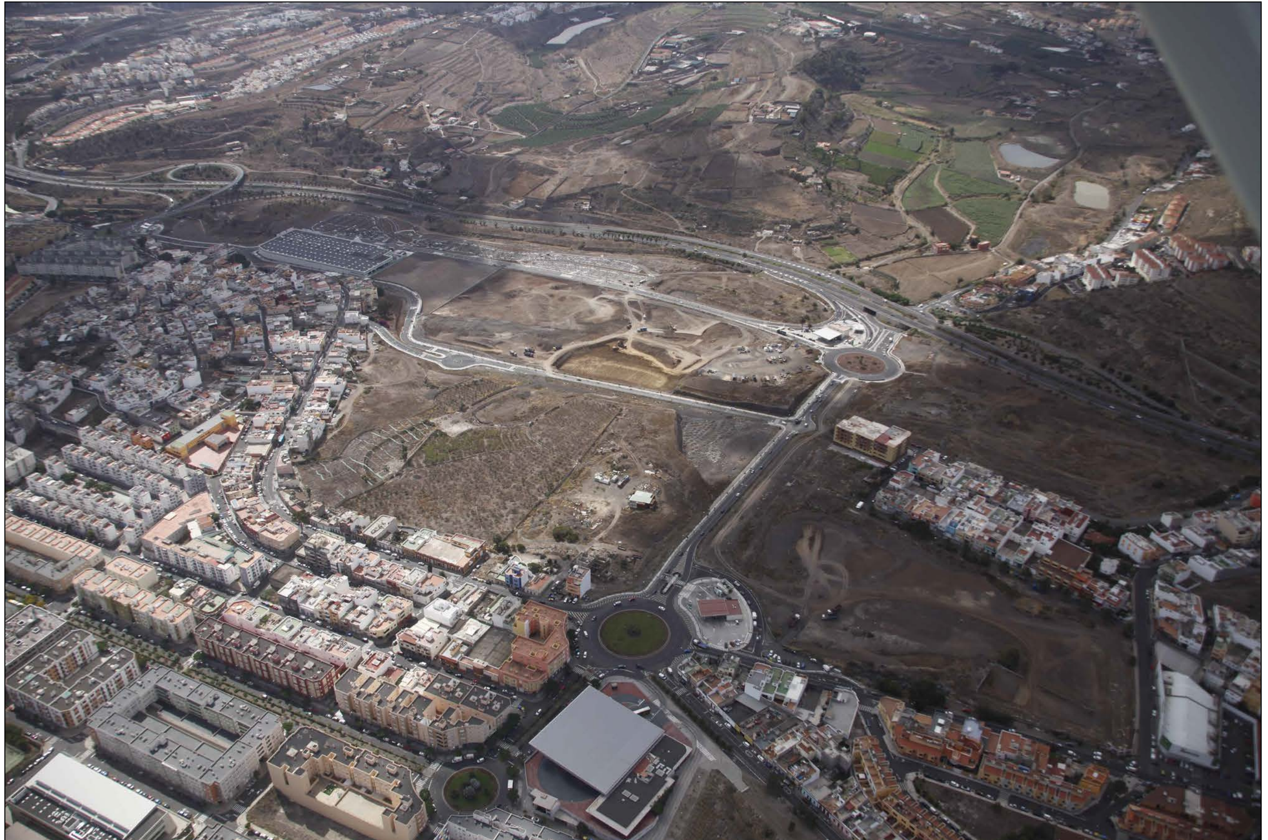
Situación ambiental de referencia. Vista aérea 2.
