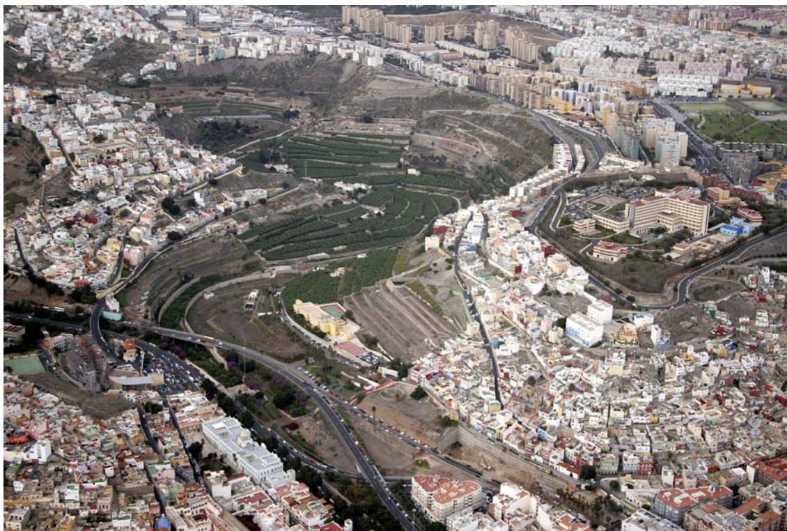
Contacto del ámbito de ordenación con las laderas-riscos urbanos y con el Barranco del Guinguada.
