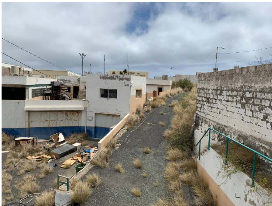
Vista interior de la parcela hacia el Este
