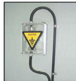
Figura 3.13: Caja de Seccionamiento de Neutro
