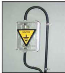
Figura 1.7: Caja de Seccionamiento de Servicio
