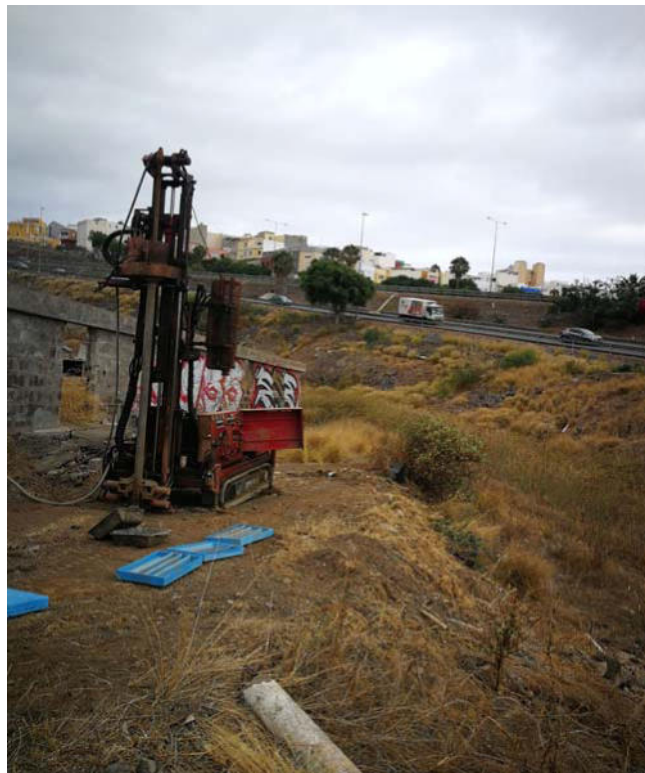
SITUACION DE SONDEO
