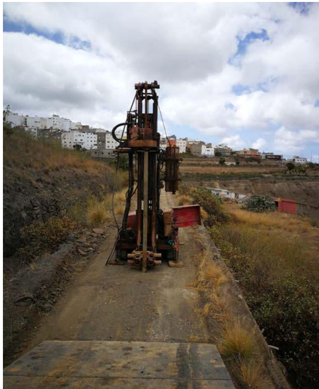
SITUACION DE SONDEO
