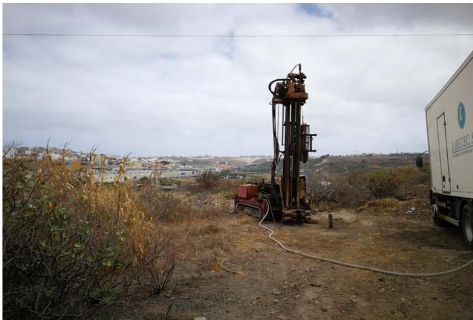
SITUACION DE SONDEO
