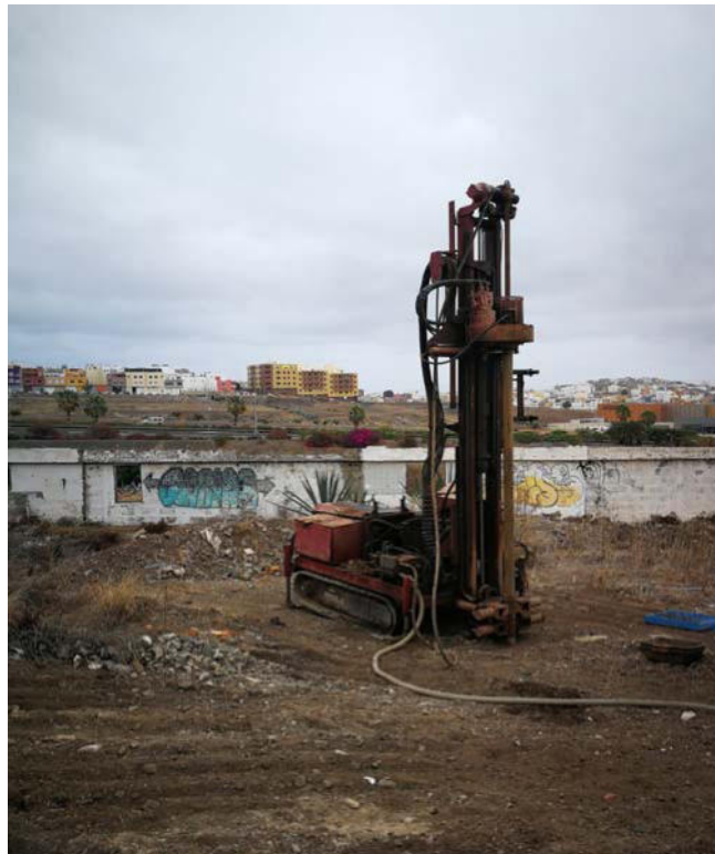
SITUACION DE SONDEO
