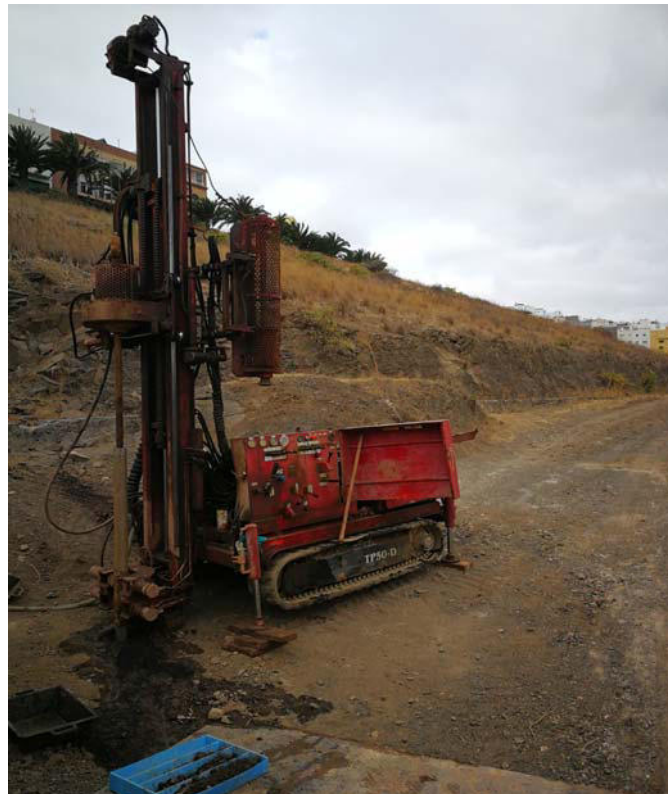
SITUACION DE SONDEO
