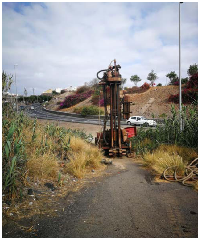
SITUACION DE SONDEO
