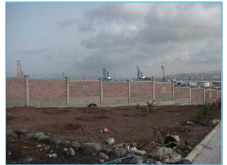
CERRAMIENTO POLÍGONO INDUSTRIAL EL CEBADAL
