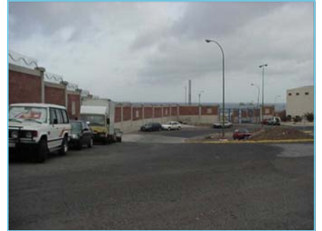
CERRAMIENTO ACCESO A LA ISLETA
