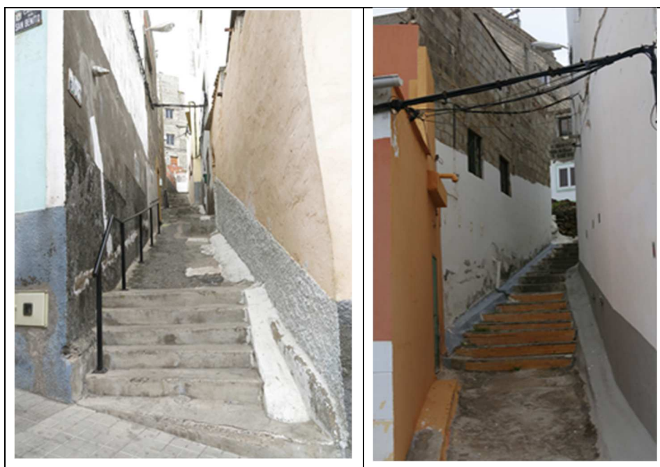
Figura 23. Imágenes de peatonales en escaleras.
