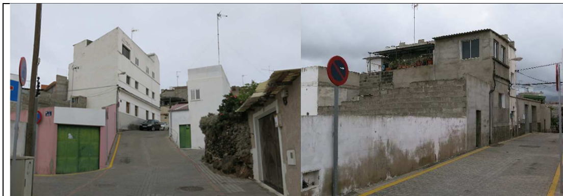
Figura 13. Ejemplos de edificaciones que no guardan relación con en el entorno, posteriores a 1975
