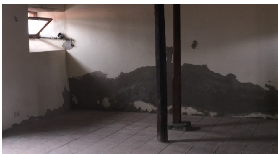
Interior de una de las crujías residenciales
