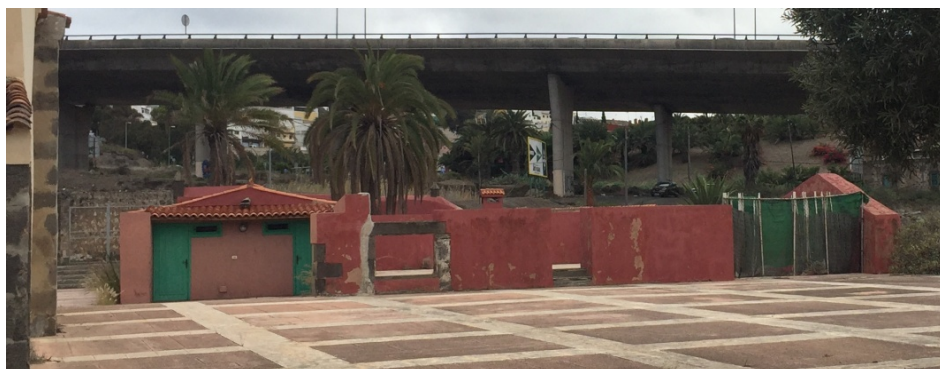
Módulo abierto al norte de La Casa del Mayordomo y las Cuarterías
