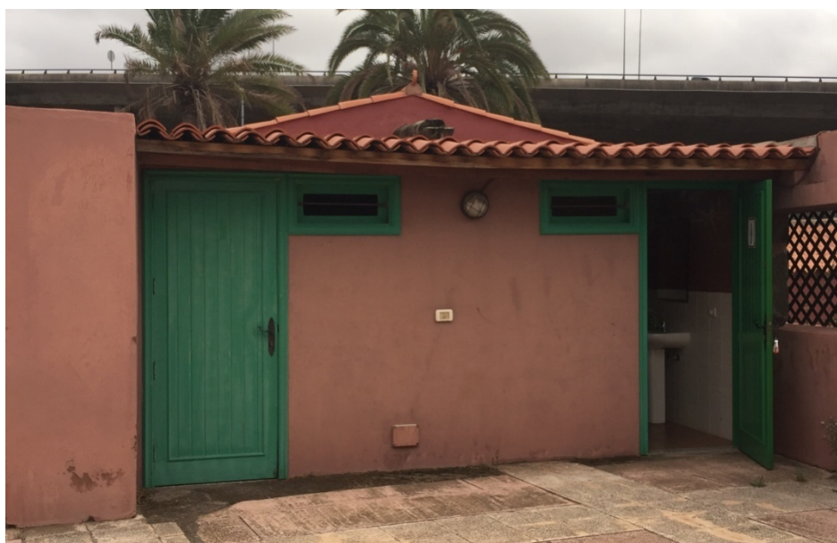
Prolongación del módulo oriental de la Casa del Mayordomo, actualmente utilizado como baño
