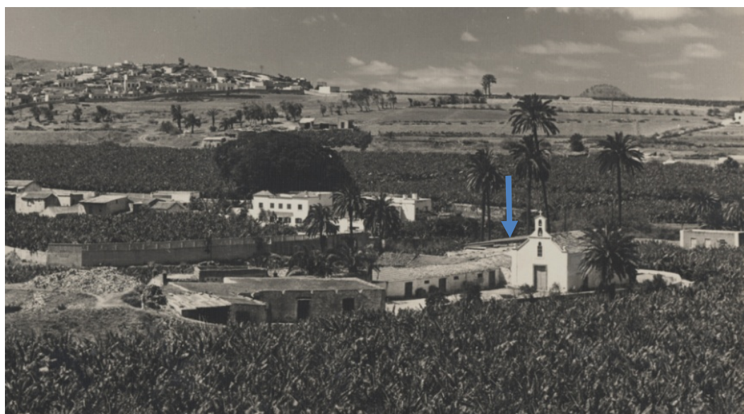
Fotografía mediados s.XX. Se indica la cubierta inclinada del antiguo almacén de plátanos. Fuente FEDAC
