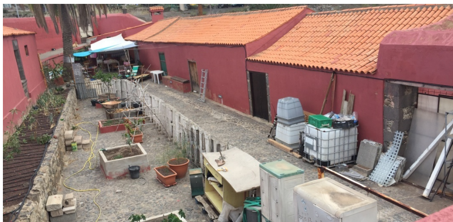
Patio interior entre la Casa del Mayordomo y las Cuarterías
