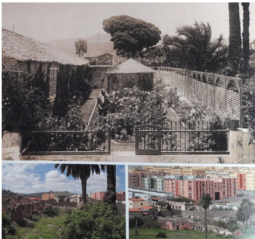
Fotografía superior realizada por Teodoro Maisch, 1928-30. El hacendado D. José Rivero Viera regando su jardín Abajo la misma casa con fotografías realizadas ca. 2014
