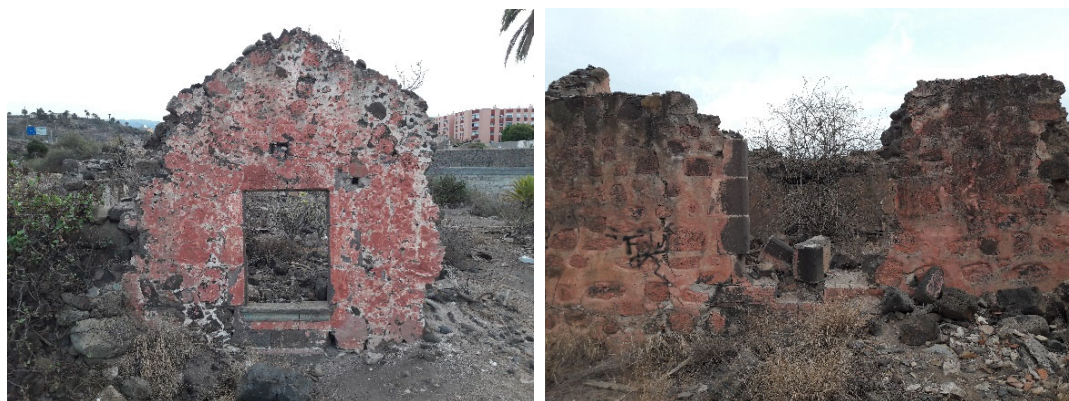
Fachadas con restos de pintura de color rojo
