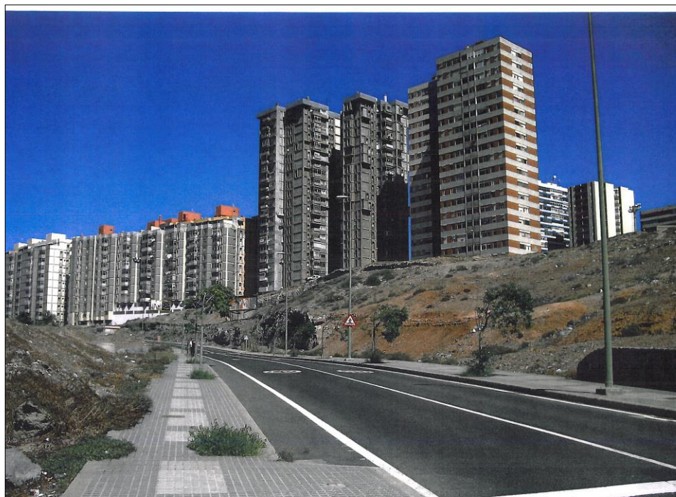
Vista desde la calle Virgen del Pilar
