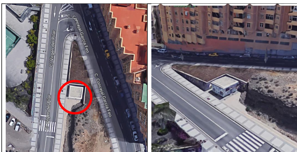
Situación de la Estación Transformadora. Fuente: Google Maps
