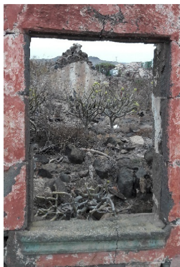
Detalle de pretil en cantería
