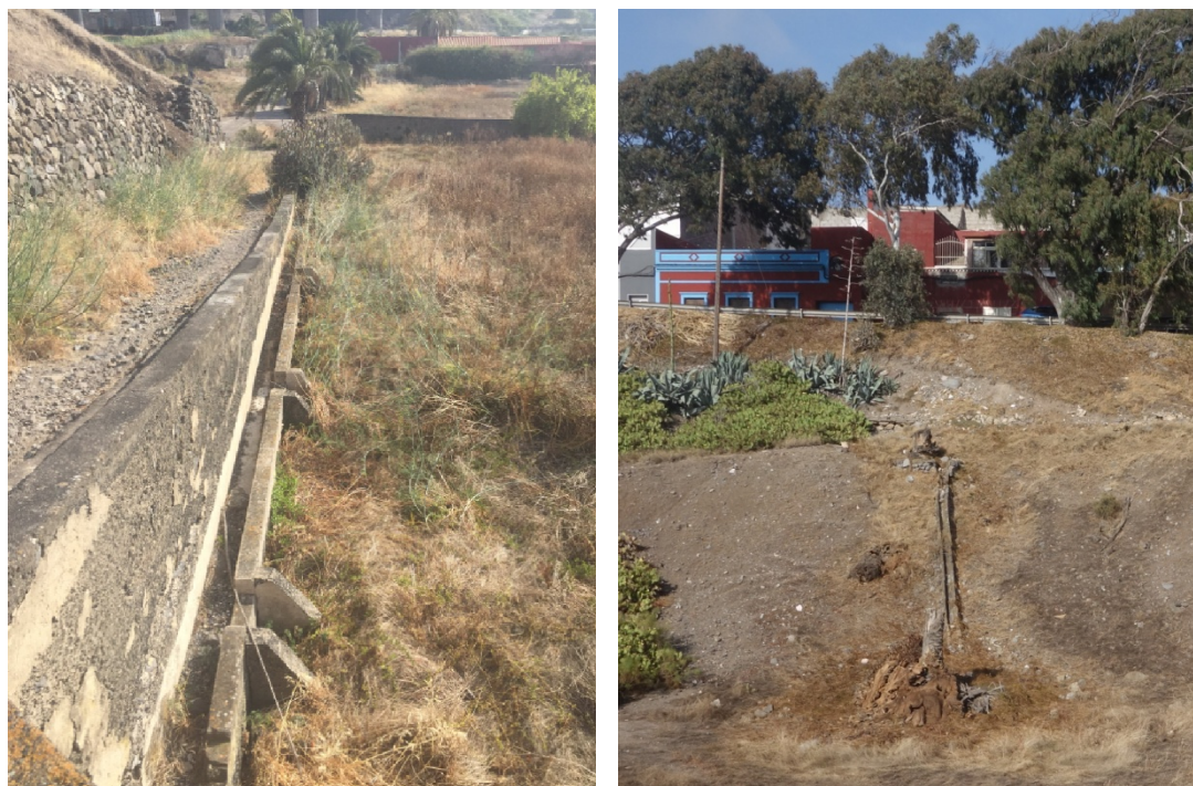
Detalles de conductos y canales de riego
