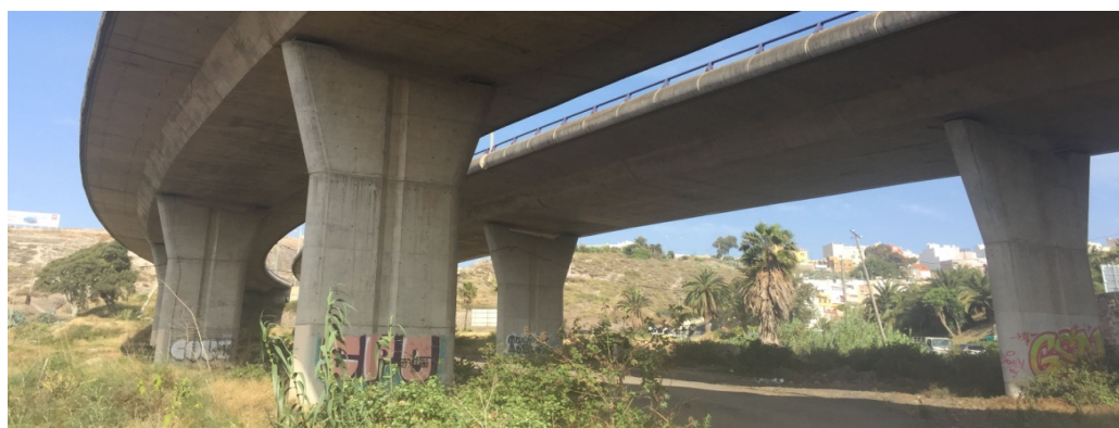
Imagen tomada en 2020 de la zona ubicada bajo la GC-03
