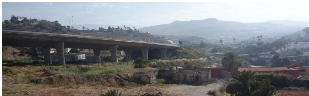
Relación de proximidad entre las edificaciones protegidas y la GC-03
