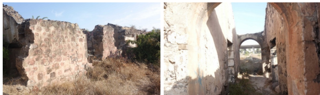
Detalle de la casa del hacendado Fachada al jardín y pasillo divisorio entre la zona de servicios y la habitacional
