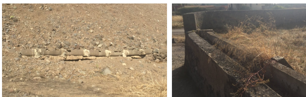
Detalles de conductos y canales de riego
