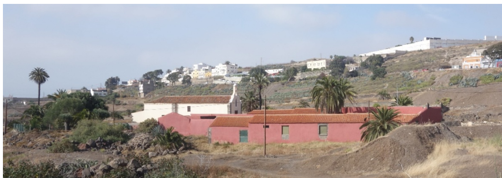
Fachada oeste del conjunto de la Casa del Mayordomo y las Cuarterías
