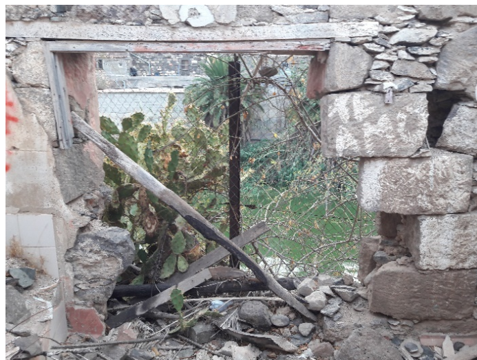
Aparejo del muro. Mampuesto y ripio
