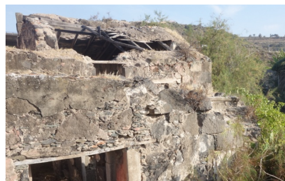
Cubierta de palos desbastados y tilla
