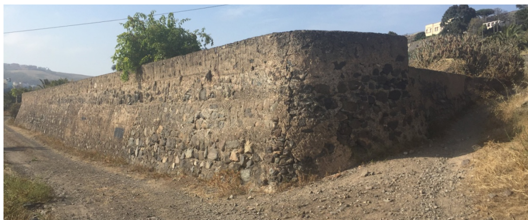
Muros de contención de los bancales
