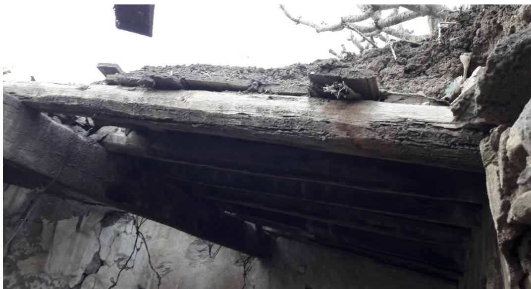
Vistas generales y detalle de la cubierta de los antiguos establos
